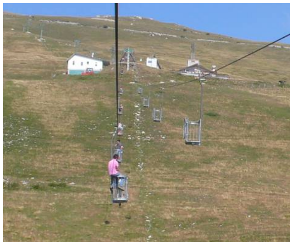
Foto 6-7: bidonvia monoposto esistente “Prada-Ortigaretta” da sostituire.
