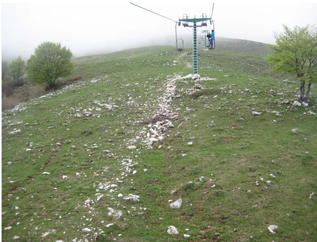
Foto 3: parte medio-alta del tracciato; la roccia calcarea (molto disgregata – “regolite”) affiora in maniera via via maggiore.
